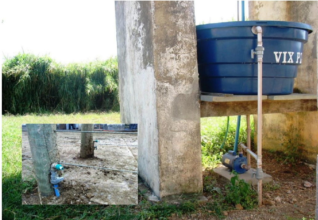
Figura 7. Equipamento utilizado para técnica Pulverizador Estacionário Motorizado. Em detalhe, as saídas da tubulação, nas laterais do corredor de contenção.
